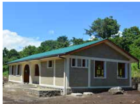
Nach nur achtmonatiger Bauzeit ist das Gebäude fertiggestellt: die Grundlage für die neue Zukunftsperspektive der Witwen
