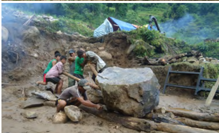
Nicht mithilfe von elektrischem Gerät, sondern mit Muskelkraft, bewältigen die Arbeiter selbst schwierigste Aufgaben
